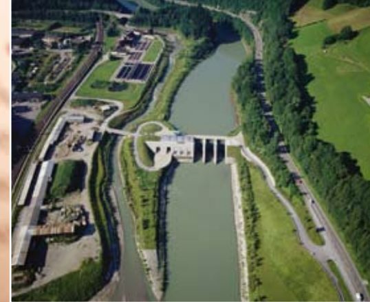
Wasserkraftwerk Kreuzbergmaut Salzburg
