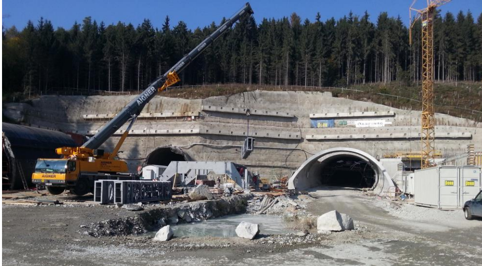
Foto: Südportal Tunnel Götschka
